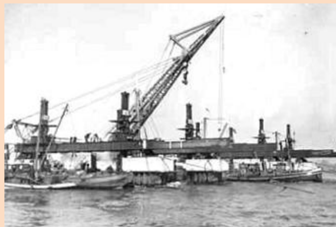
Het lichten van de PRINS WILLEM V. Tekening: RWS, Nationaal Archief. Foto: maritiemdigitaal.
