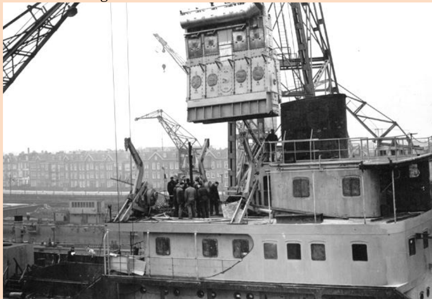
PRINS WILLEM GEORGE FREDERIK, plaats van de Werkspoor hoofdmotor. (Foto: NN/Collectie A.K.J. Niemants-verdriet).
