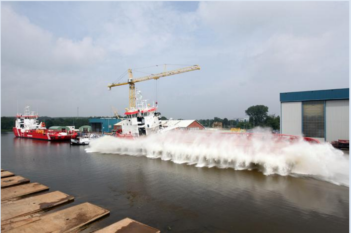
SERKEBORG 9621534, in aanbouw bij Koninklijke Niestern Sander B.V. te Delfzijl onder bouwnummer 845 voor Wagenborg Kazakhstan B.V., Delfzijl, 28-6-2012 te water gelaten, tweede in een serie ice-breaking-multipurpose supportvessels met een trekkracht 34 ton, speciaal ontwikkeld voor logistieke dienstverlening aan de olie- en gasindustrie in de Kaspische Zee, de geplande oplevering is begin september 2012.
