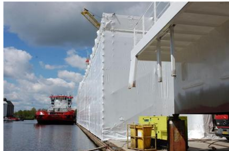
WATERMAN bij Kon. Niestern Sander te Delfzijl, als nieuw na werfbeurt, op de achtergrond de in aanbouw zijnde SANABORG 9621522 en SERKEBORG, ingepakt als een kunstwerk van Christo; het onderwaterschip wordt gezandstraald. Foto's: B.H.F. Spruit, 13-5-2012).
