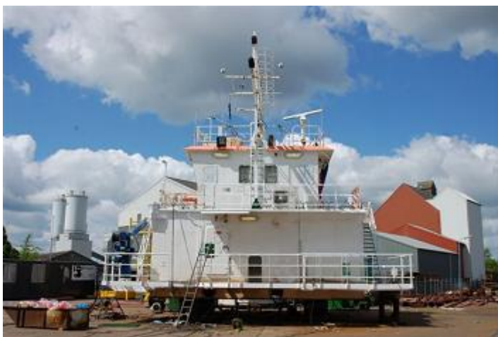
JOHAN VAN VEEN 9098971, hopperzuiger/splijtbak van Van Oord Overig Materieel I B.V., Rotterdam, bouwjaar 2007, 827 BRT, opbouw (foto links) op de kant bij Kon. Niestern Sander te Delfzijl tijdens een verbouwing, er wordt een extra verdieping opgebouwd, 14-4-2012 gearriveerd te Delfzijl vanaf Algeciras achter een sleepboot. Rechts de opbouw van de in aanbouw zijnde EXEBORG. Foto's: B.H.F. Spruit, 13-5-2012.
