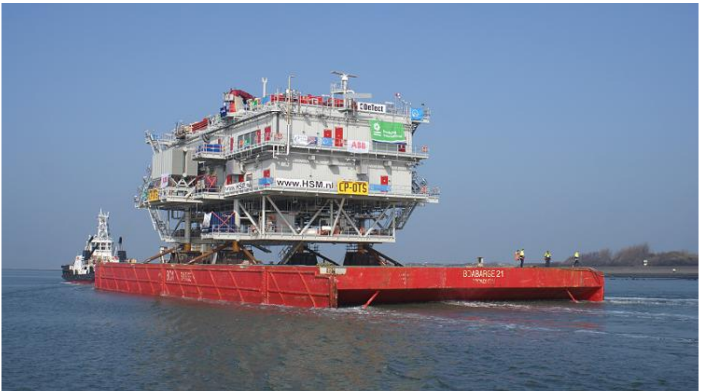
CP-OTS gebouwd door HSM Offshore B.V., Schiedam, plaats: Noordzee bij de Belgische kust, afmetingen: 45,00 x 45,00 x 20,00 meter, gewicht: 2.000 ton, besteld: 8-2010 door ABB. (foto's: T. Koornhof).
